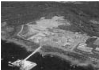
原子力発電所
